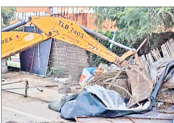
सोनीपत। टोल प्लाजा पर जेसीबी से अवैध निर्माण को तोड़ा गया।
